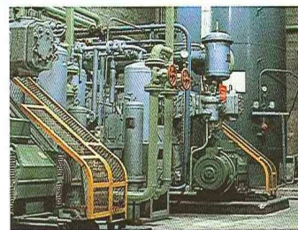
Sala de calderas, factoría química, Francia. Protección con una sola capa de CombiColor.
